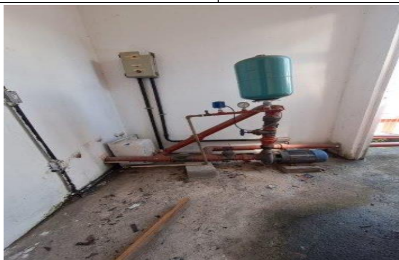
Foto 05 – Bomba de combate a incêndio, sem utilização.
